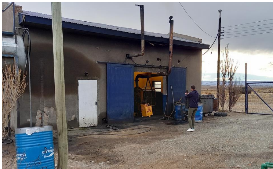
Figura 91 - Sala de grupos electrógenos de SPSE en Bajo Caracoles
