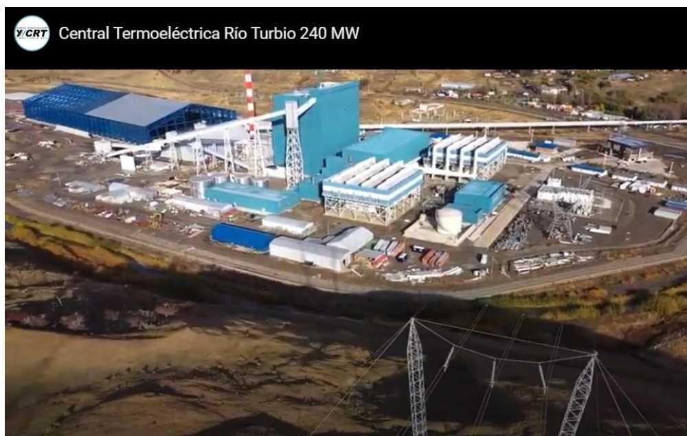
Figura 58 CTRT – vista aérea y conexión al SADI en 220 kV [YCRT,2023]
